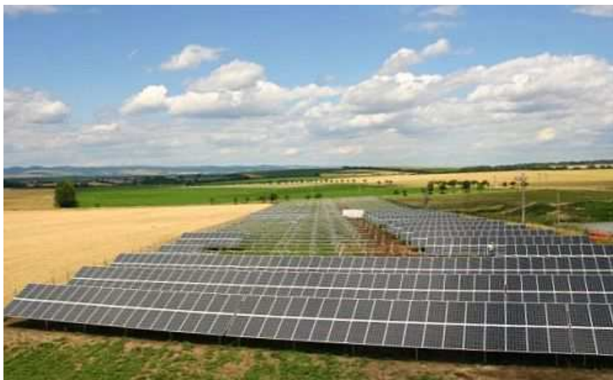
Obr.6 Plochy solárních elektráren vyvolávají vzhledem k minimální drsnosti a stoupavým vzdušným proudům změny v proudění vzduchu – ovlivňují mikroklima. Zdroj: HiTechSolar
