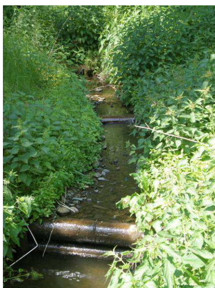
Obr.6 Stabilizace koryta nad přehrázkou V Oblouku
