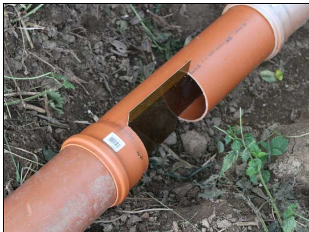
Obr.5 Na sběrné potrubí byly instalovány dělicí kusy
