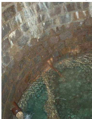
Obr.3 Šachtová studna zděná
