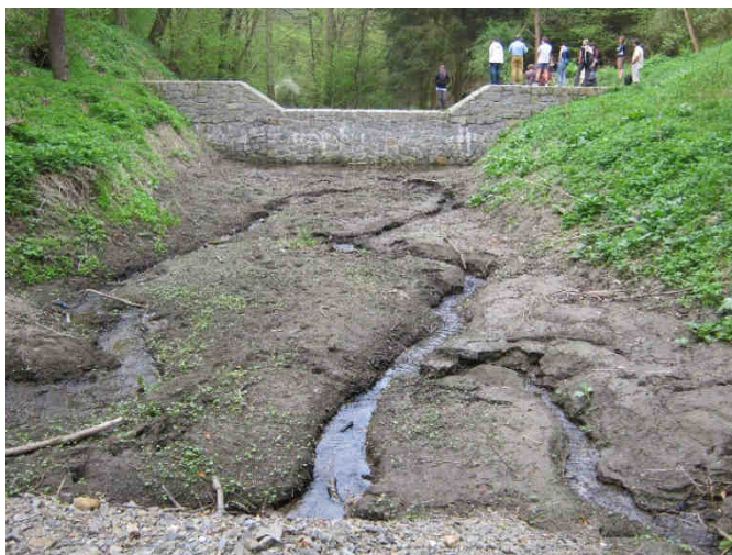
Obr. 2: Pohled po proudu na retenční prostor přehrážky
