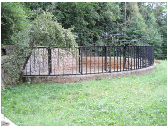
Obr. 1: Šachtový bezpečnostní přeliv na VD Les Království
