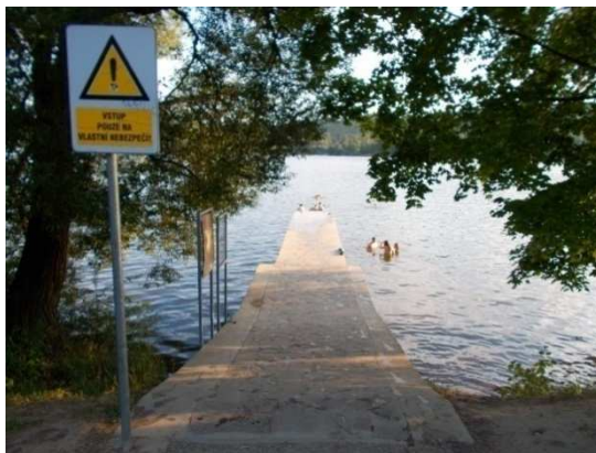
Obr. 2: Přístup do vody z betonového mola v lokalitě Sokolské koupaliště[6]
