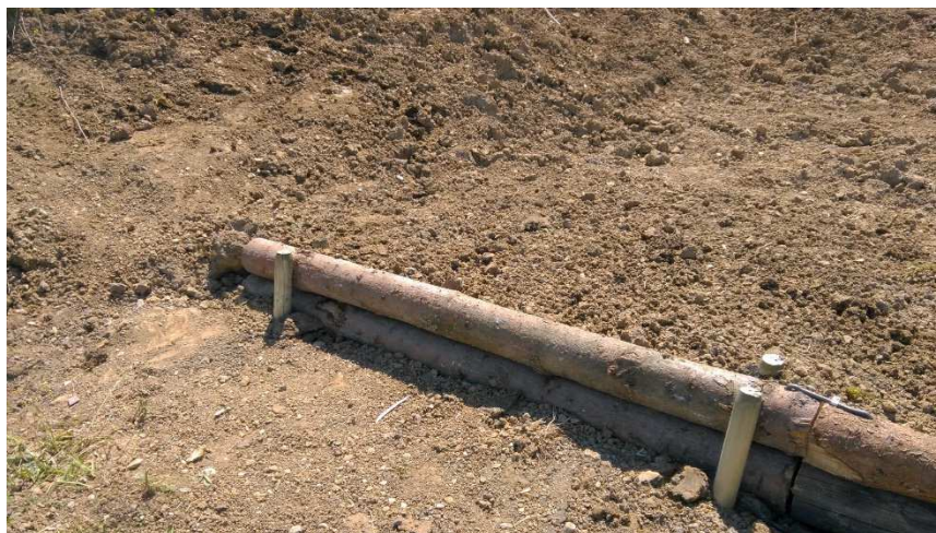
Obr. 5: Realizace biotechnické stabilizace – plocha 2
