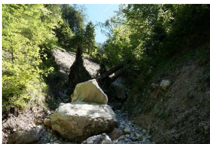
Obr. 7: Zřícená přehrážka H2
