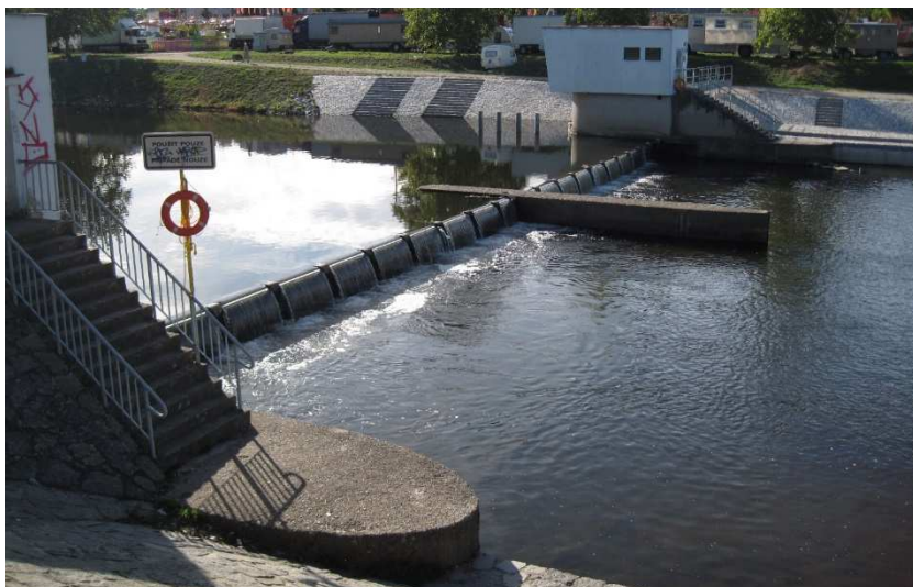
Obr. 1: Stabilizační jez Křemelka ve Strakonících
