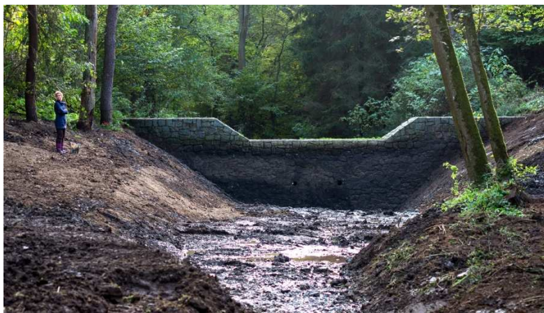
Obr. 1: Pohled do vytěženého retenčního prostoru z místa vtoku
