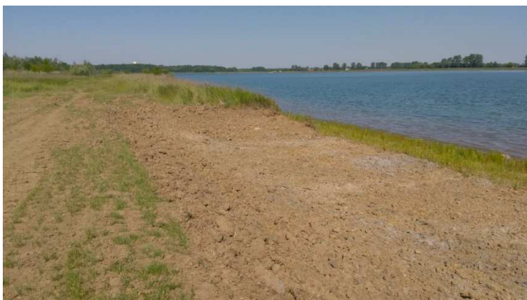
Obr. 7: Realizace biotechnické stabilizace – plocha 3
