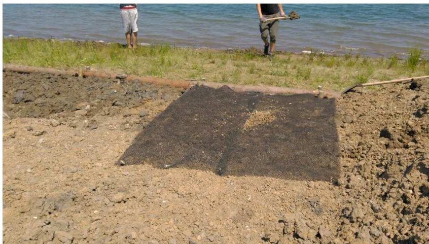
Obr. 3 Realizace biotechnické stabilizace - plocha 1
